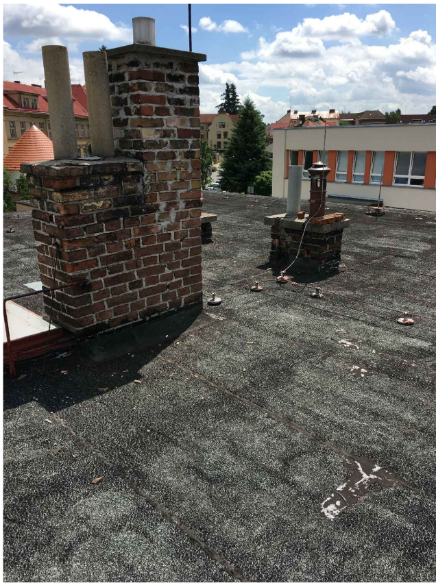
komínová tělesa budou ubourána a nově postavena z mrazuvzdorných cihel - komíny budou postaveny ve stejné hmotě s původními
