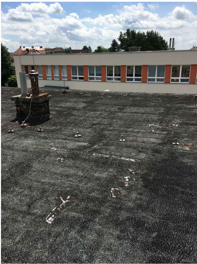
komínová tělesa budou ubourána a nově postavena z mrazuvzdorných cihel - komíny budou postaveny ve stejné hmotě s původními
