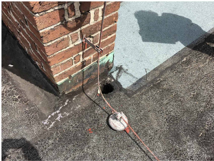
stávající střešní vpust - pozice bude zachována, nové bude osazen tepelně izolační vtok s nástavcem a záchytným košem
